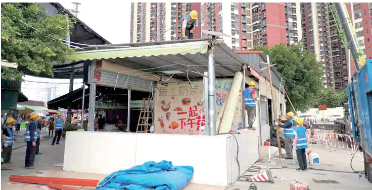
■桂城街道查治办组织拆除违法建筑。(通讯员供图)
