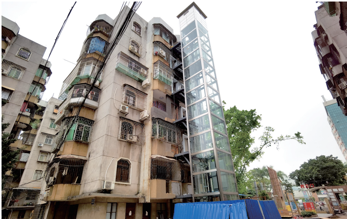
■海棠村小区旧楼加装电梯。
