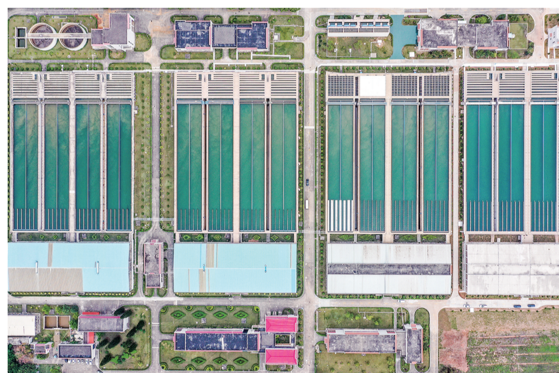
南海第二水厂的平流沉淀池,俯瞰之下十分壮观。
