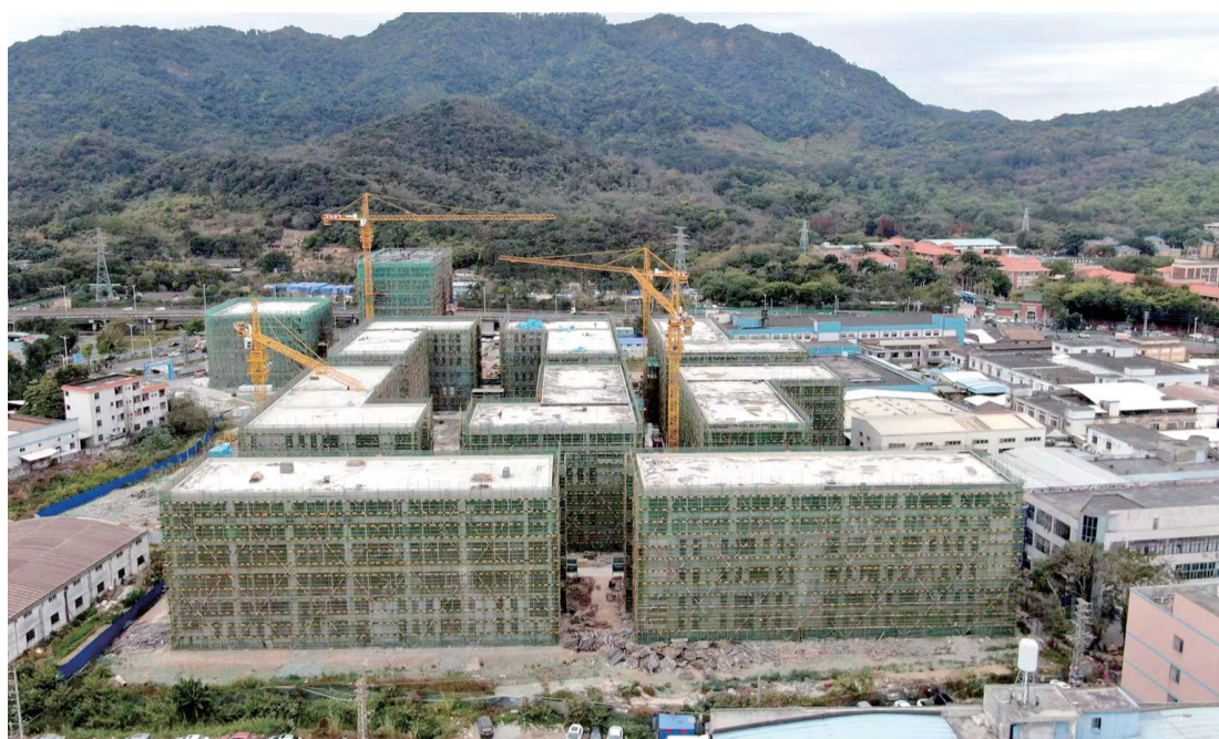
正在加紧推进的五八科创园项目。
