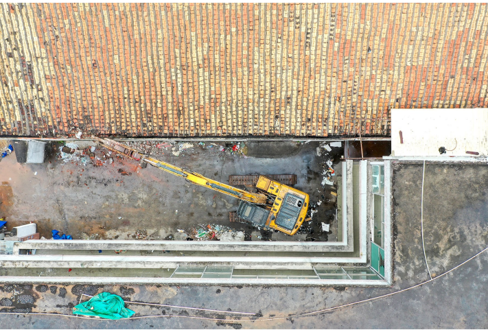
南海区村改大攻坚现场会桂城分会现场拆除现场。
