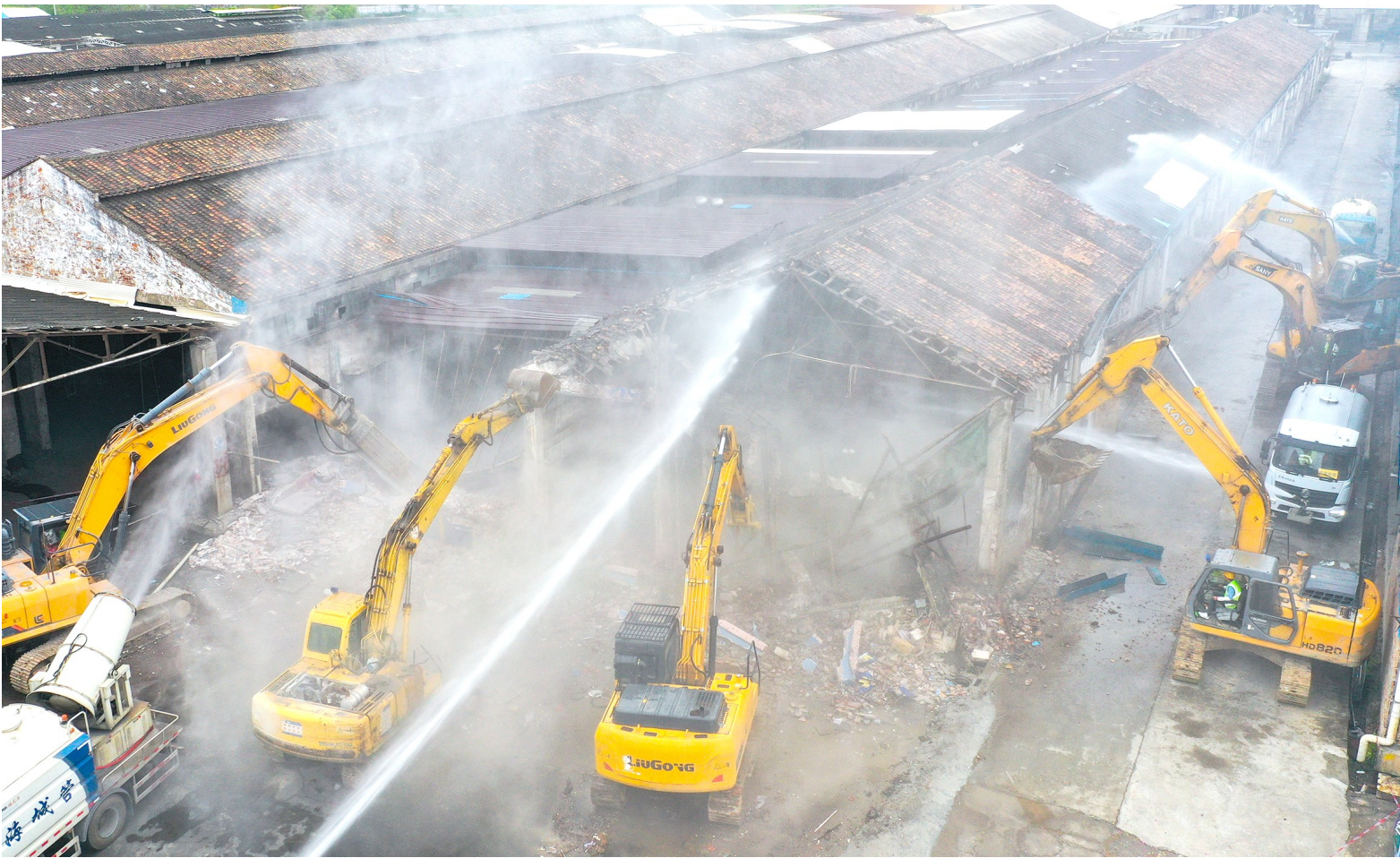
南海区村改大攻坚现场会西樵分会现场,挖土机开始拆除。
