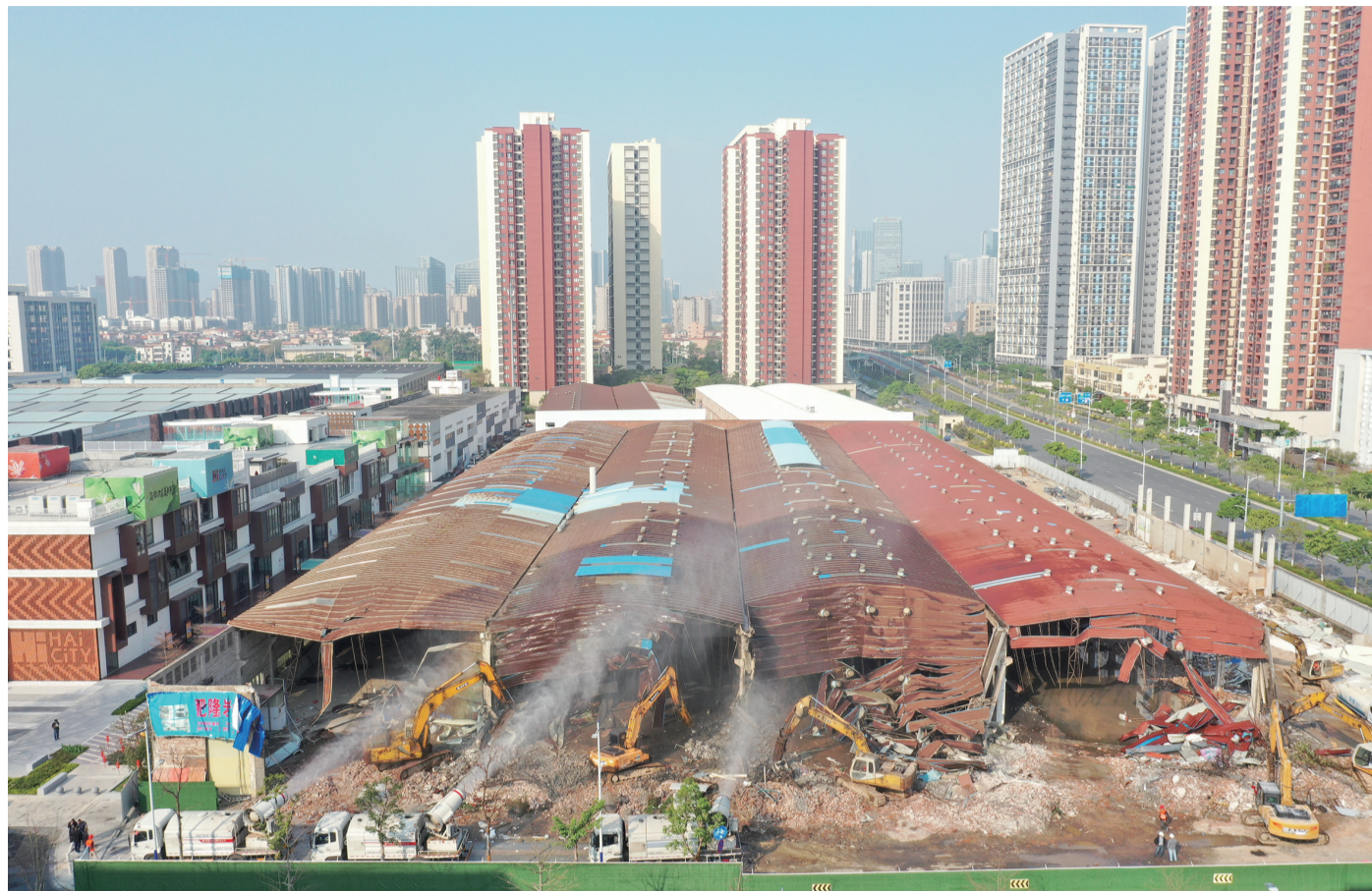
■桂城夏南片区村级工业园连片改造项目，现场对旧厂房进行拆除。
