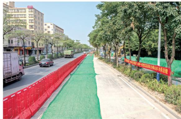
里水牛屎涌片区和泥涌涌补水工程对沿途14条河涌进行生态补水，目前已铺设约6.7公里补水管。
