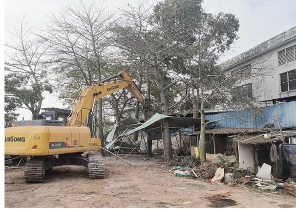
■工作人员用钩机对抢搭的简易镀锌铁棚进行拆除。
