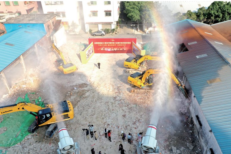
■桂城夏西平穩工业区拆迁现场。
