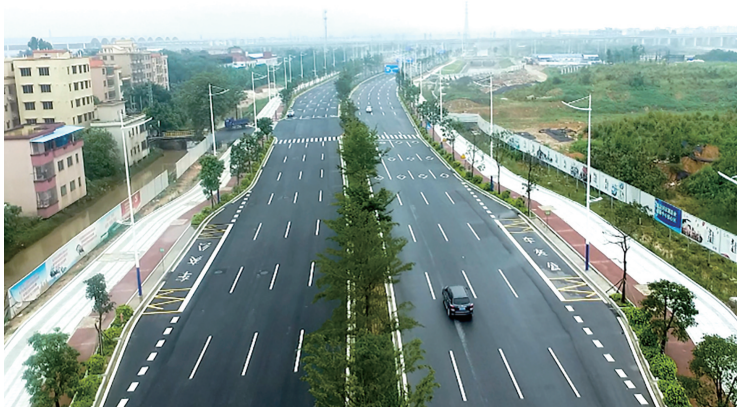
■佛山西站环站西路(站前北路-兴业路)道路工程。(通讯员供图)
