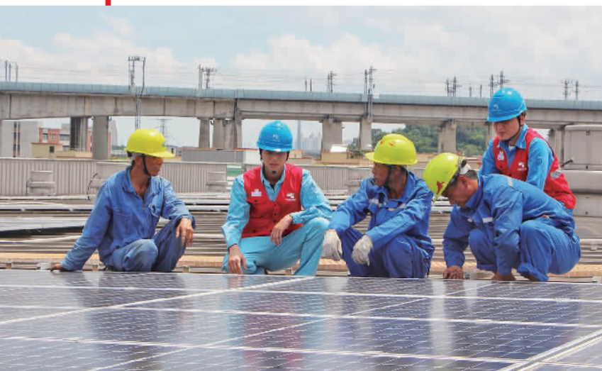
佛山南海供电局桂城供电所工作人员到普洛斯三山物流园开展光伏用电检查。(部门供图)
