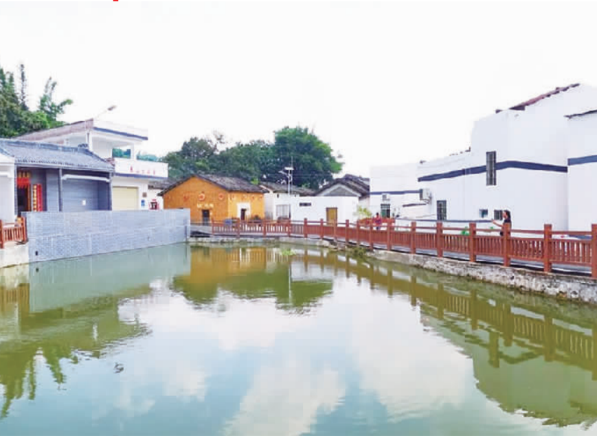
■上洞村的新农村建设取得了可喜的成效,图为东山池塘。
