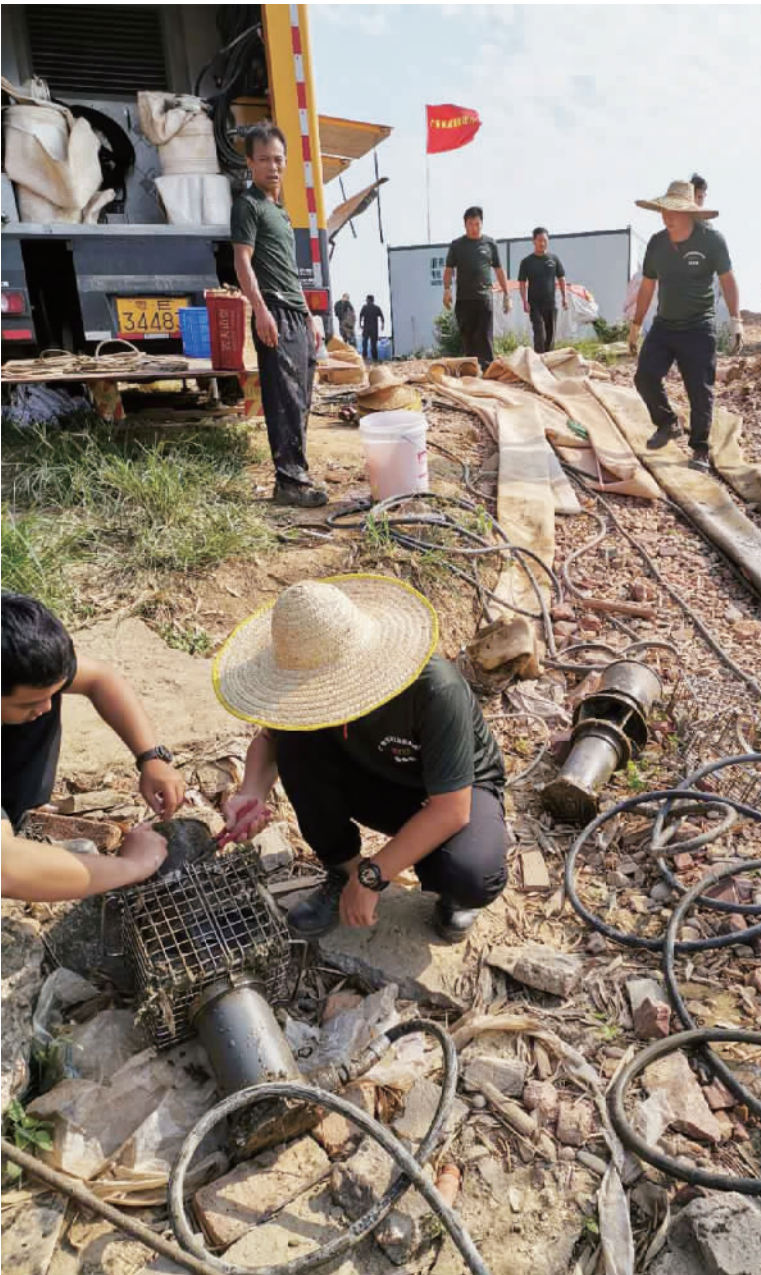
■南海抢险队员每天24小时不间断作业执行排水抢险任务。
