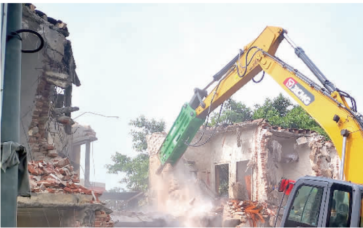
■拆除现场。(通讯员供图)
