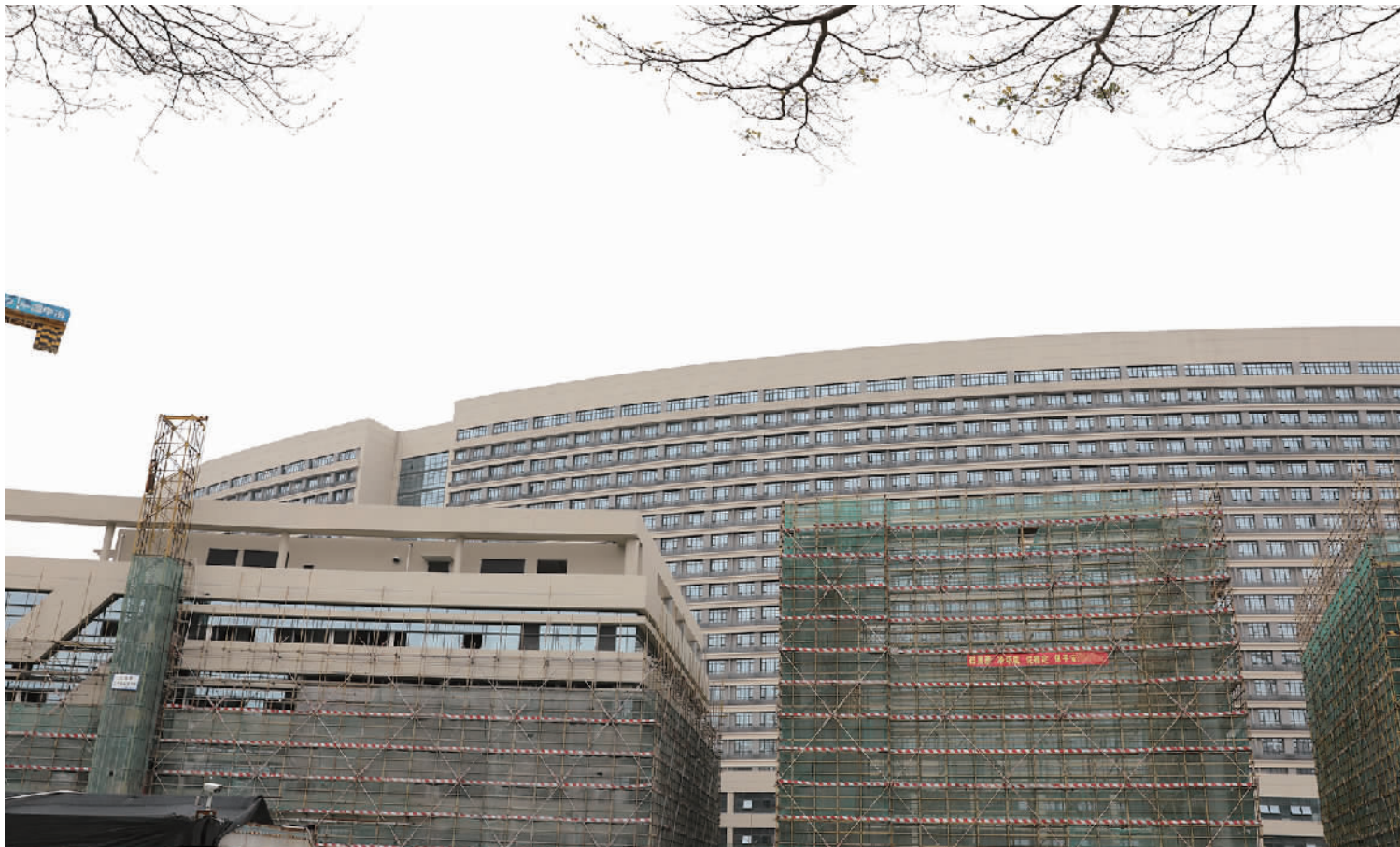
■南海区人民医院新院区主体建筑全部封顶,进入机电安装和室内装修阶段。
