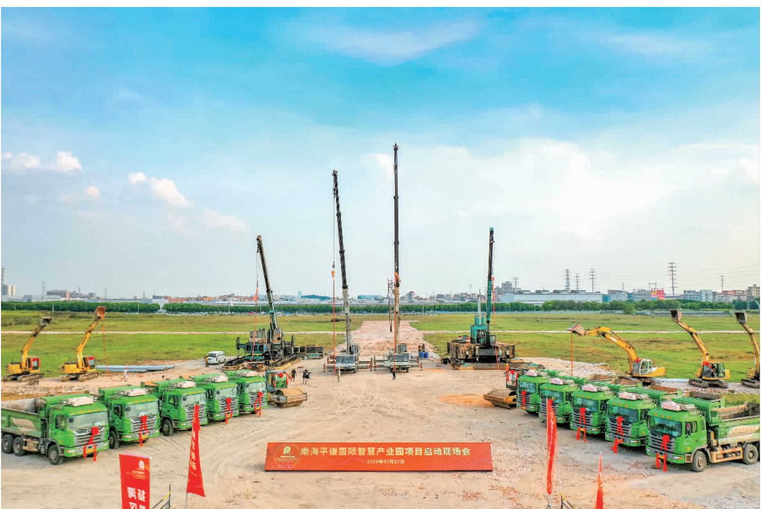
■7月27日,南海平谦国际智慧产业园项目在狮山启建。 通讯员/张嘉敏 摄
