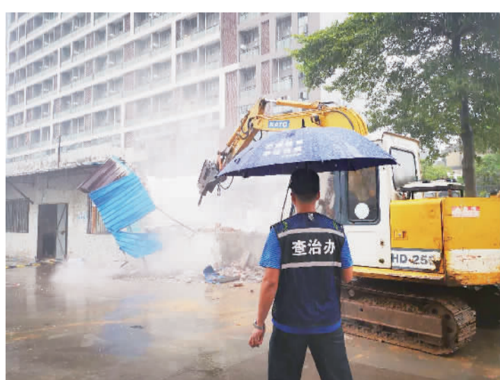
■桂城街道查治办拆除违建。
