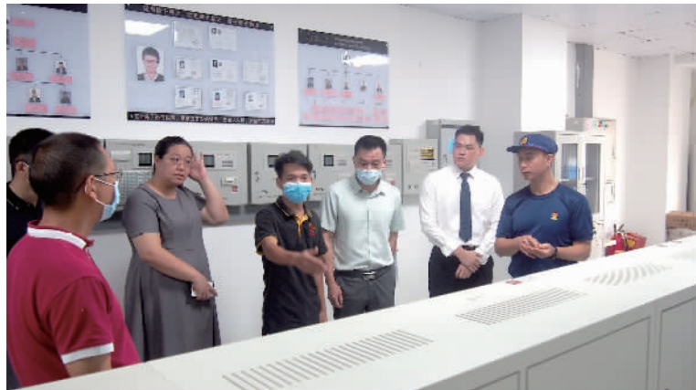
■执法检查组检查西樵观心小镇消防控制室。
