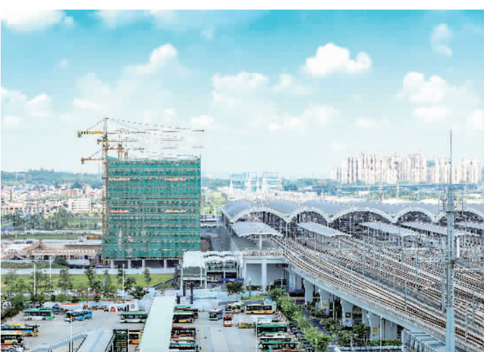
■佛山西站南广场大楼加紧建设中。
