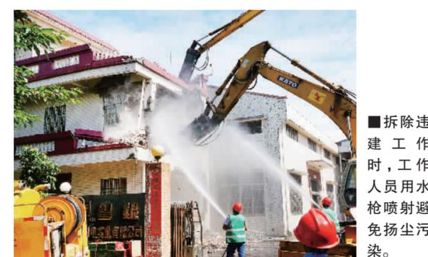
拆除违建工作时,工作人员用水枪喷射避免扬尘污染。
