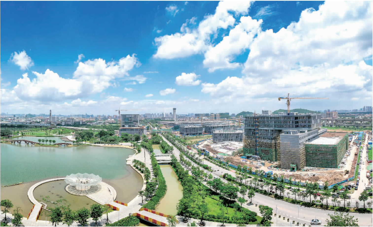
■首批4家广东省实验室之一的季华实验室一期已完成建筑主体封顶,将在今年下半年投入使用。
