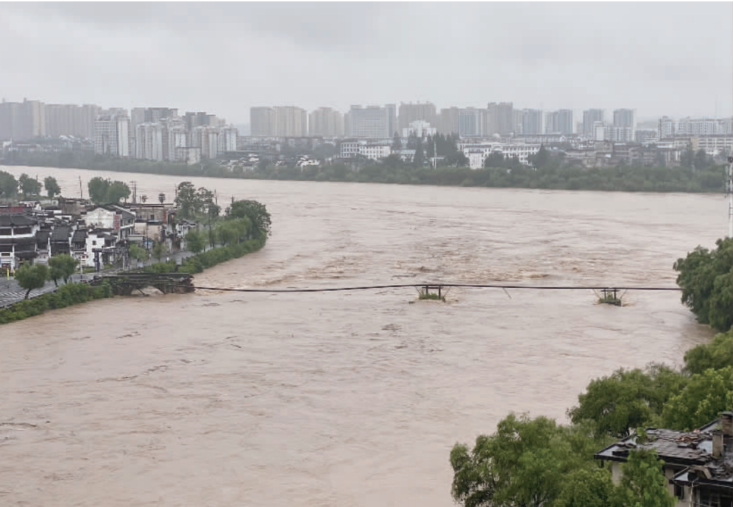
■7月7日,安徽黄山屯溪老大桥被洪水冲垮毁坏。屯溪老大桥又叫镇海桥,始建于明代。 新华社发
