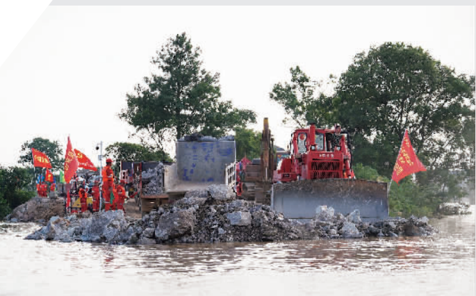
■这是7月12日拍摄的鄱阳县万亩圩堤问桂道圩施工现场。
