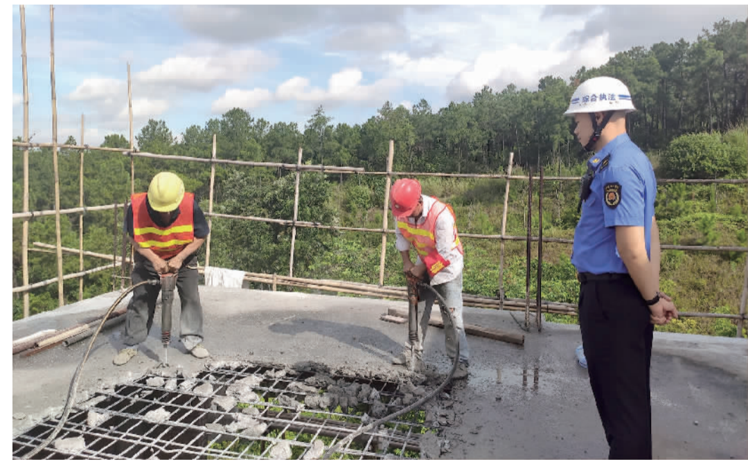
■施工人员对加建部分进行破坏性拆除。
