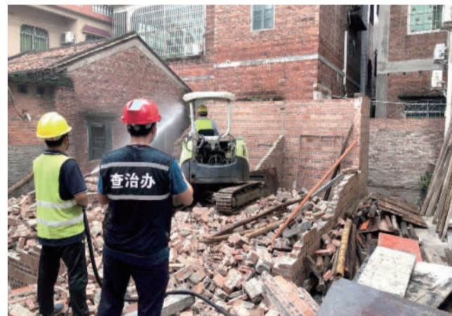
■施工人员拆除宅基地违建。
