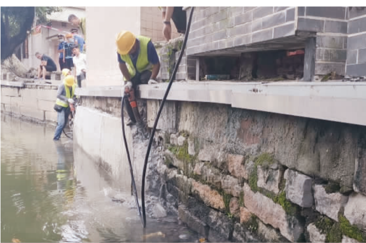
■专项工作组拆除叠北社区河堤违建。
