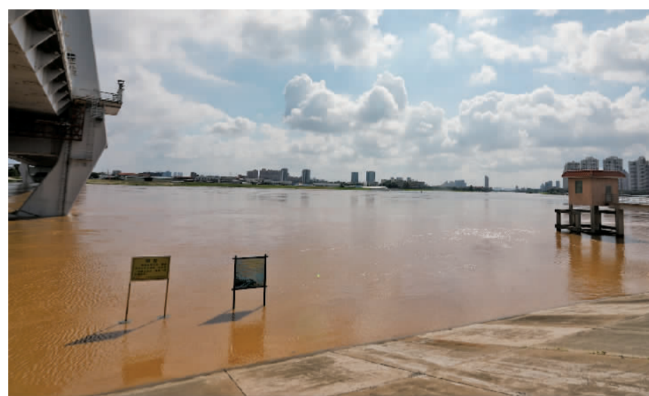
西樵龙湾基险段水位缓慢回落。珠江时报记者/戚伟雄摄
