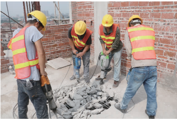
■施工人员拆除违建楼板。
