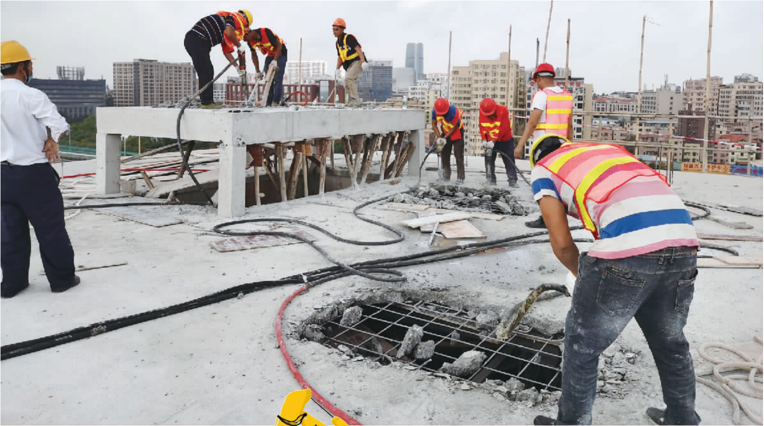
■工作人员拆除违建物。(通讯员供图)
