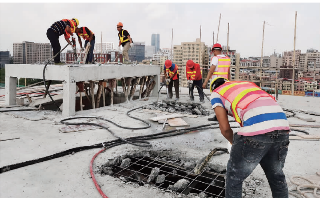
施工人员拆除违建楼板。
