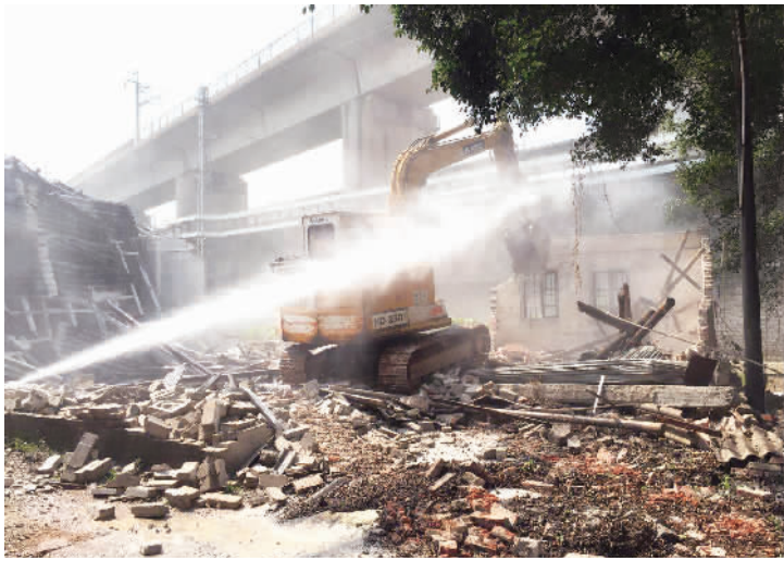
■施工人员使用钩机对违建进行拆除。
