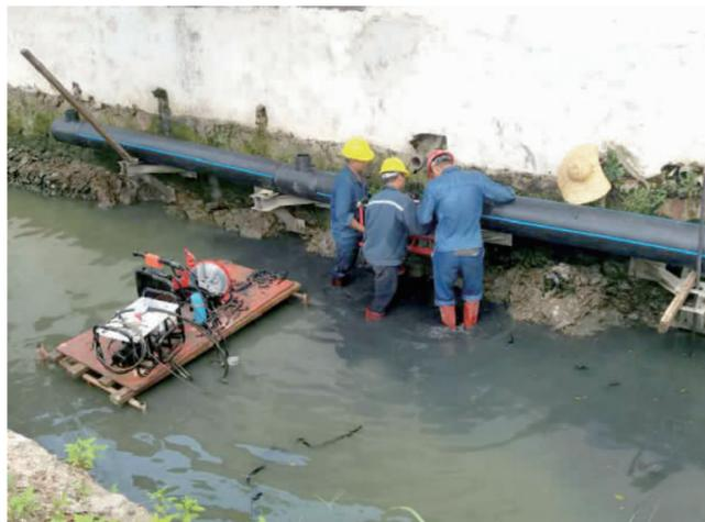
■施工人员在里水北沙社区的沙洛涌铺设污水管网。
