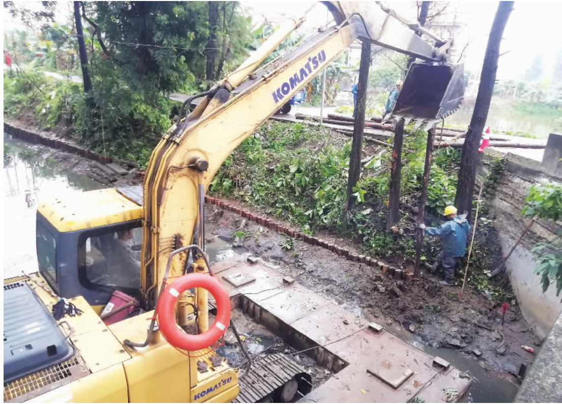
■施工人员在打木桩护岸。
