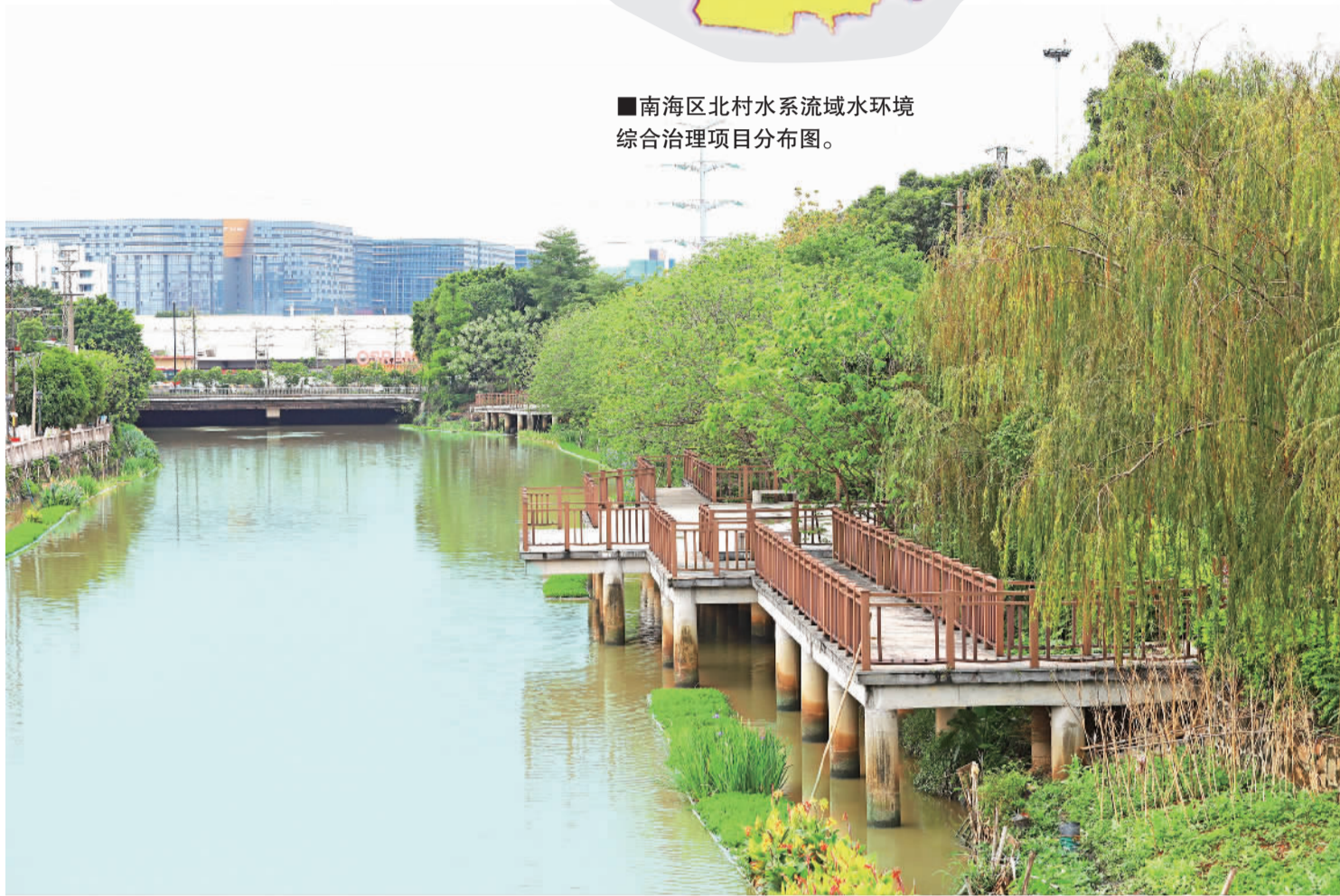
■南海谢边涌。南海区将实施五大工程推进科学治水。
