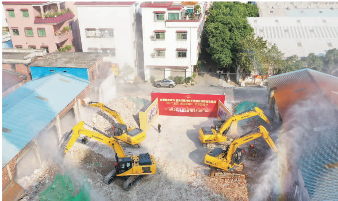
■桂城街道夏西平稳工业区拆迁现场。
