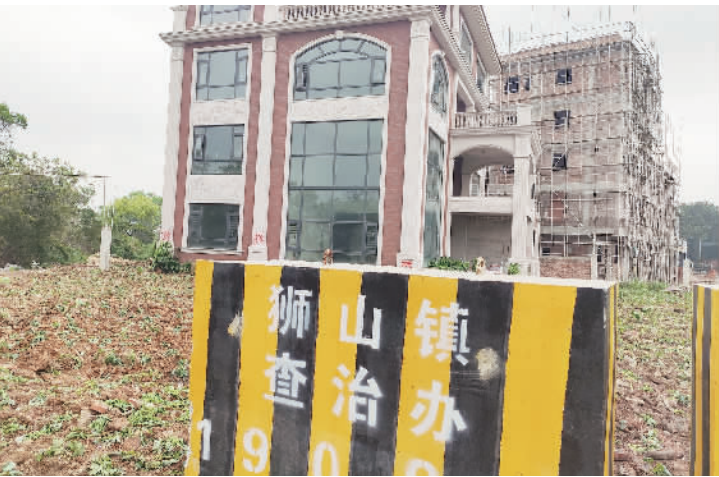
■狮山镇对狮岭村一处宅基地违建的围墙、水泥地面进行拆除并封闭现场。
