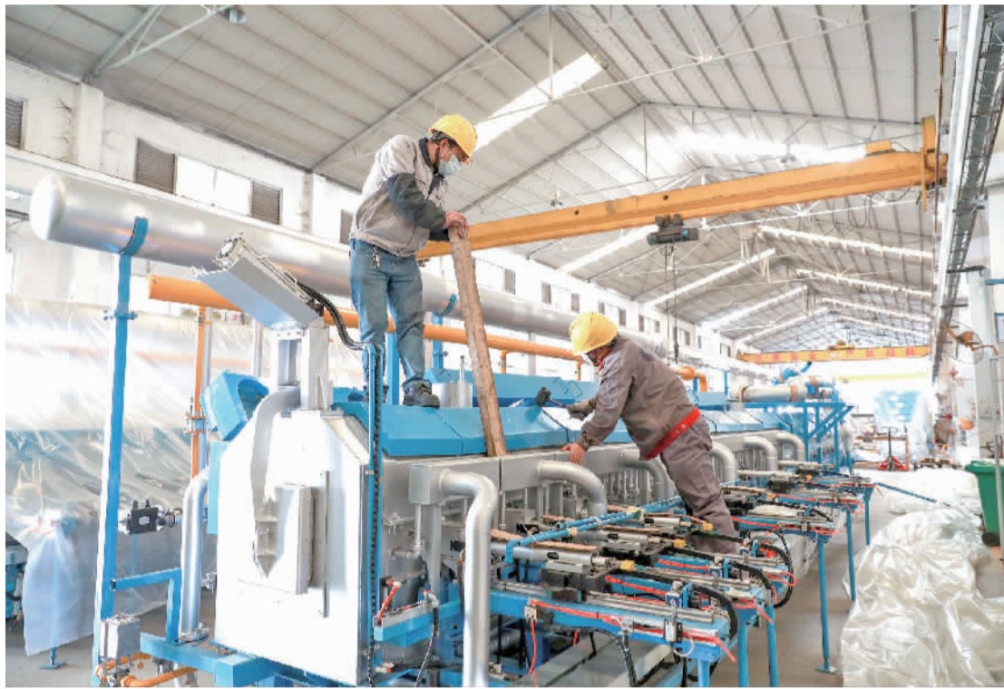
■考迈托(佛山)挤压科技股份有限公司车间,工人复工安装设备。
