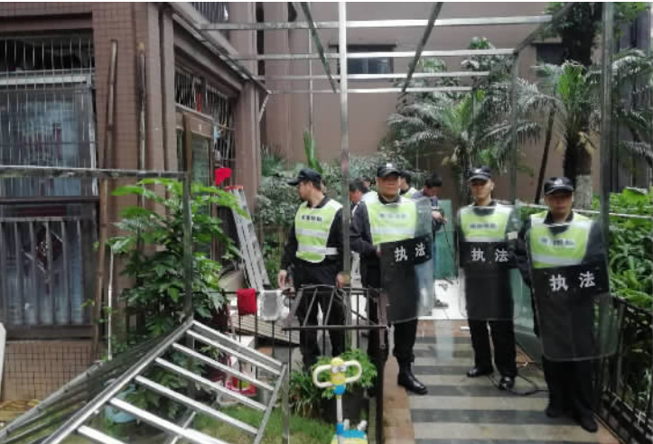
◀2019年5月8日,执法人员对长信银湾某住户违建进行快速拆除。(通讯员供图)
