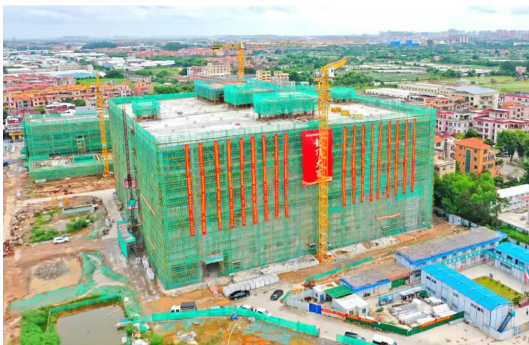
■腾龙湾区数据中心项目一期封顶。
