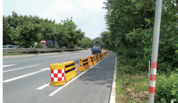
■新田村红绿灯至南海发电厂路段,自行车及电动自行车专用道建设基本完成。
