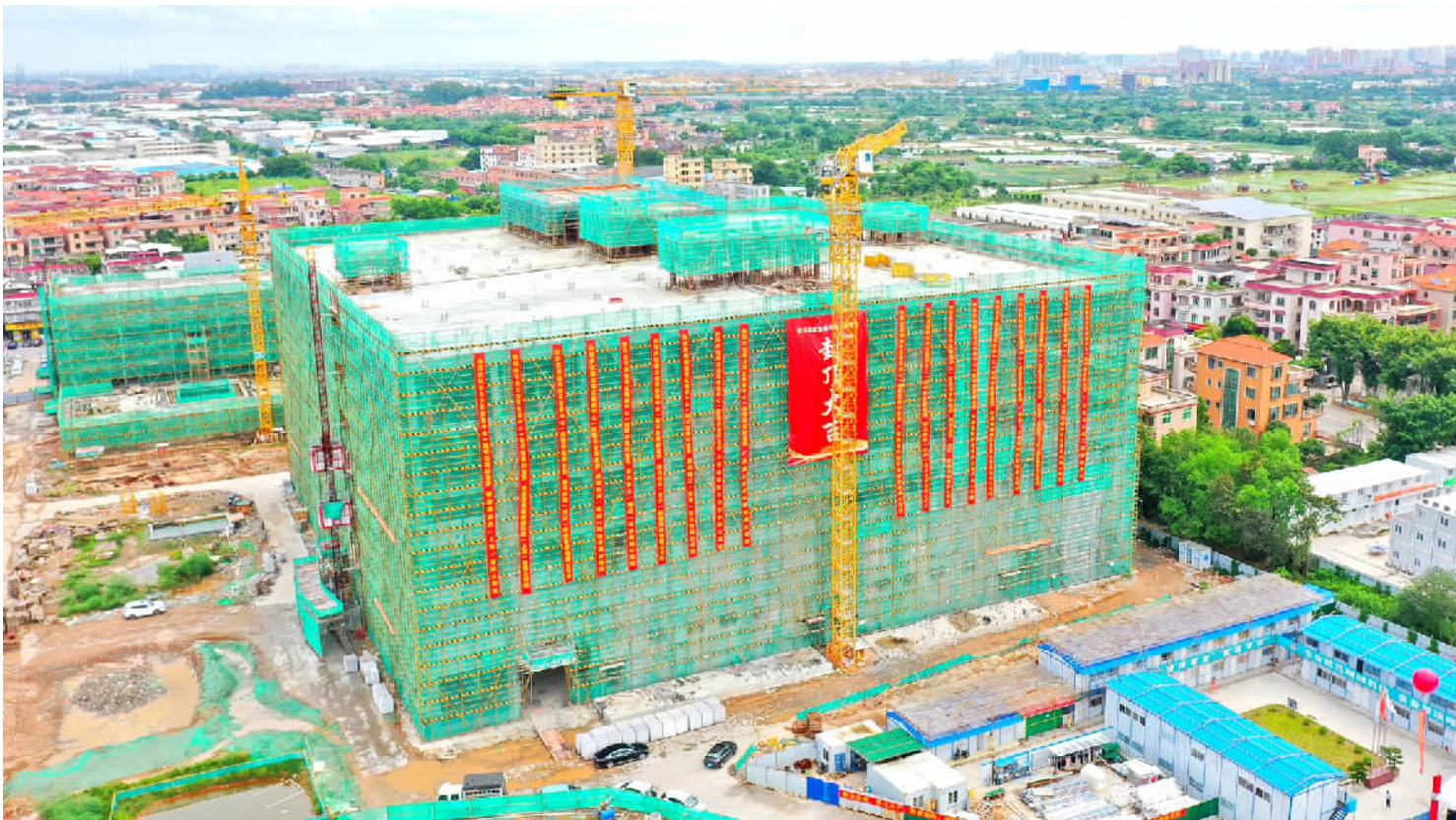
■腾龙湾区数据中心项目一期封顶。
