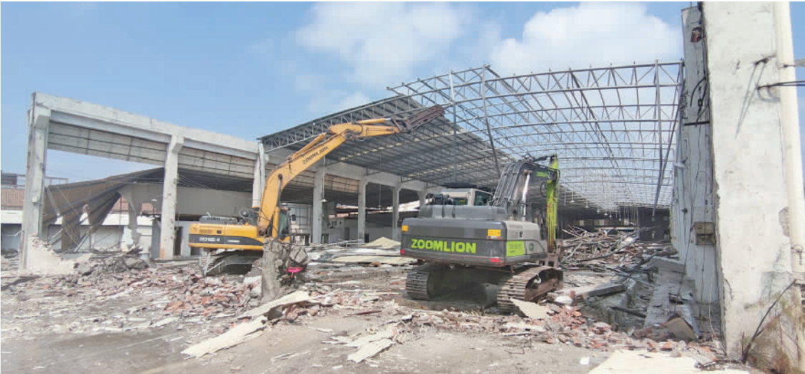
■新田景开智造园项目拆除现场。
