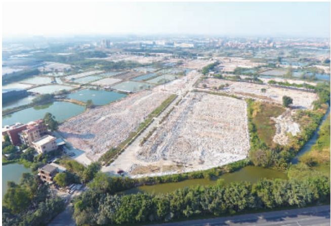
■听音湖拓展区项目现状。
