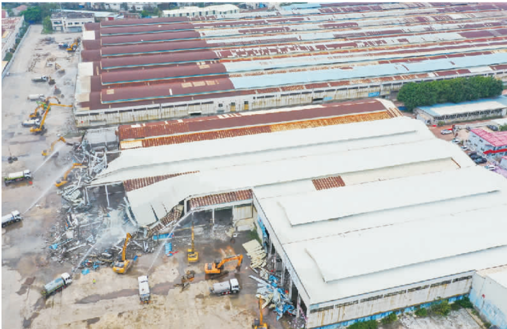
■山南产业社区项目的拆除现场。
