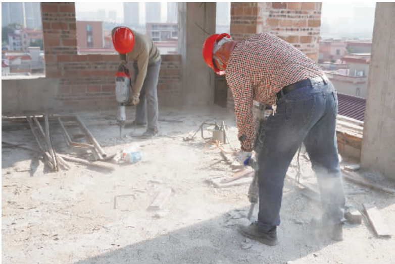
■工程队对该宅基地超高部分楼层施行破坏性拆除。
