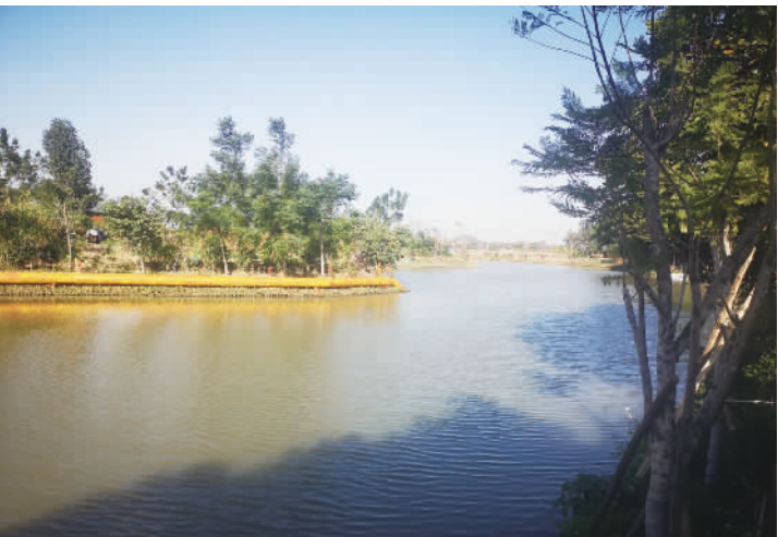
■碧道建设工程二期禄舟主排涌(儒溪一岭西段)已基本完成。
