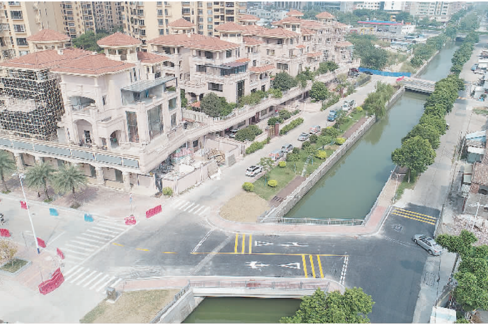
■西樵太和窠中心涌跨线桥启用。通讯员供图
