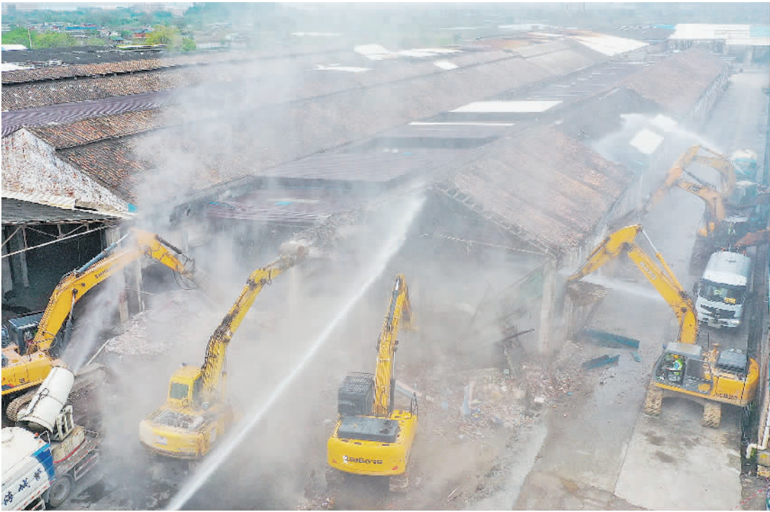
■南海区村改大攻坚现场会西樵镇分会场拆除现场。
