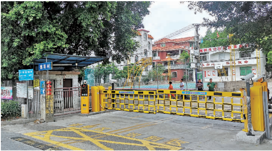
■山根社区樵阳村的出入口装上了电子闸口和车牌识别系统。
