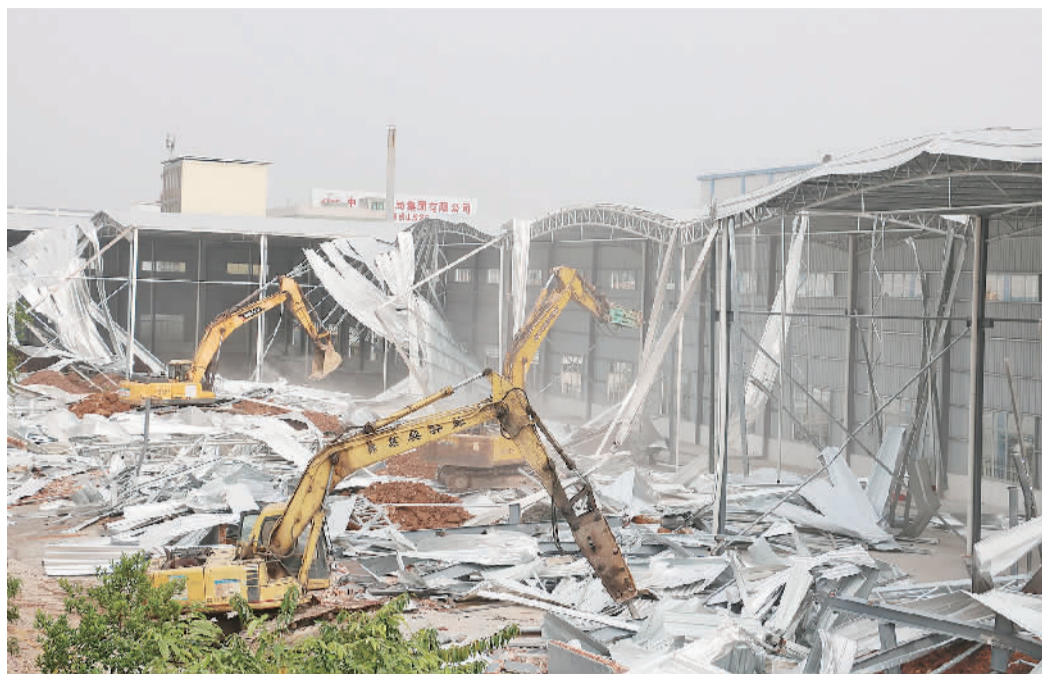
■执法队伍对违建厂房进行强制拆除。
