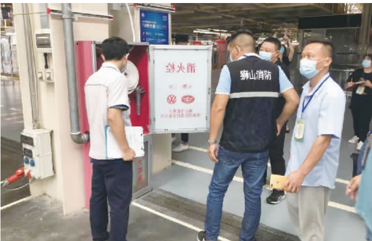
■检查人员携安全专家进企业检查消防安全隐患,并给出整改意见。(通讯员供图)
