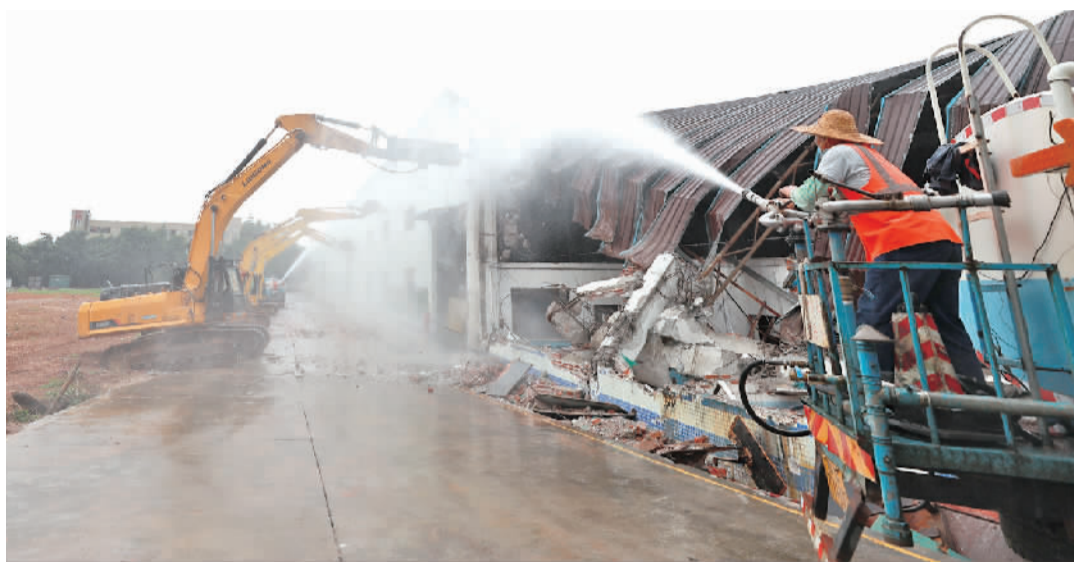
■狮山镇松岗富豪网络线材厂地块改造项目现场,钩机拆除老旧建筑。
