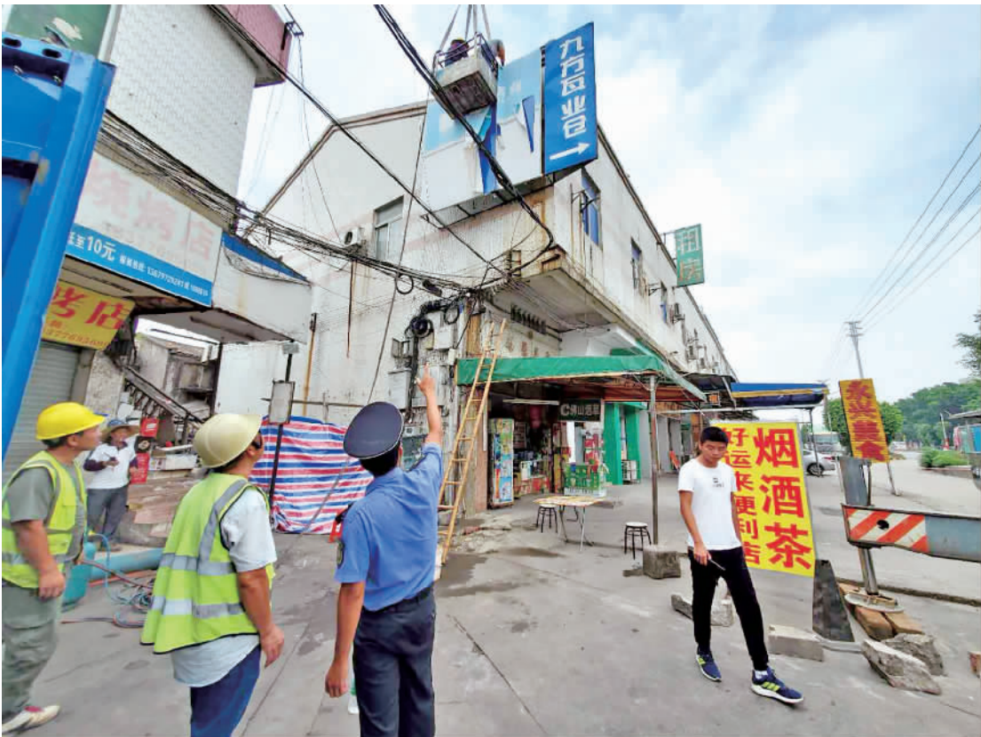
■执法人员拆除楼顶广告牌。
